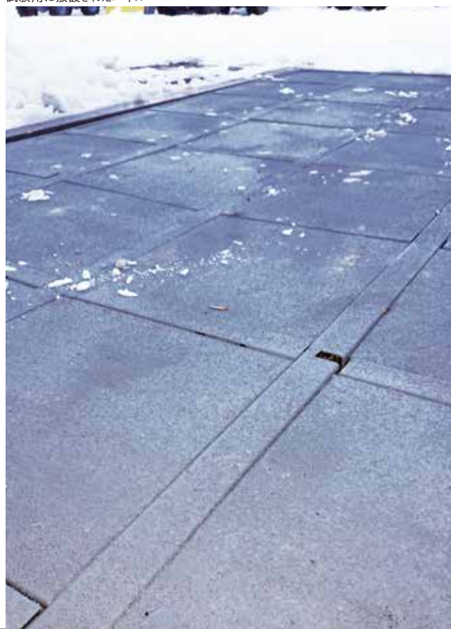
試験用に敷設されたパネル
